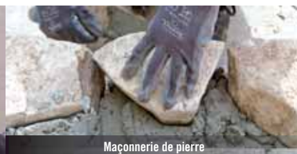
Maçonnerie de pierre
